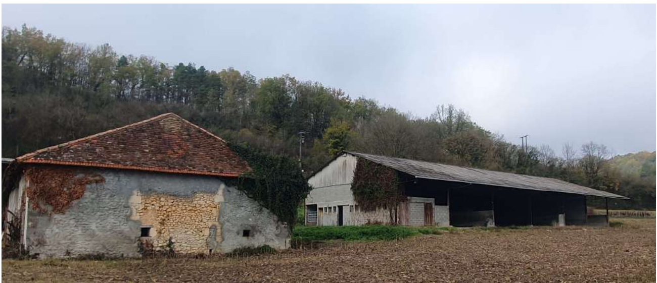
Détail 2 _ Ensemble bâti AE 5/7 (habitat / hangar agricole)
