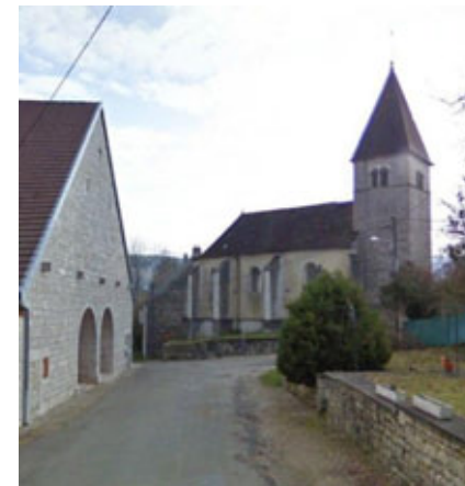
L'alternance du bâti et d'espace vert diversifie les lieux. Les murets de soutènement en pierre local traite la pente dans le débouché de la Loue
