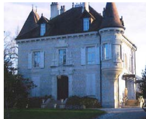
ELEMENT BATI N°4 : Château : rue du Château
