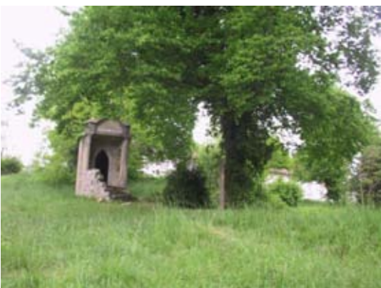
ELEMENT BATI N°31 : Chapelle : chemin de Bauquet
