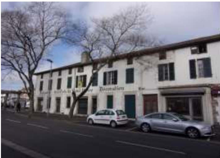
Dégradation lourde : réhabilitation globale de l'immeuble. 2 locaux commerciaux et 9 logements (1 studio, 3 T2, 4 T3, 1 T4).
