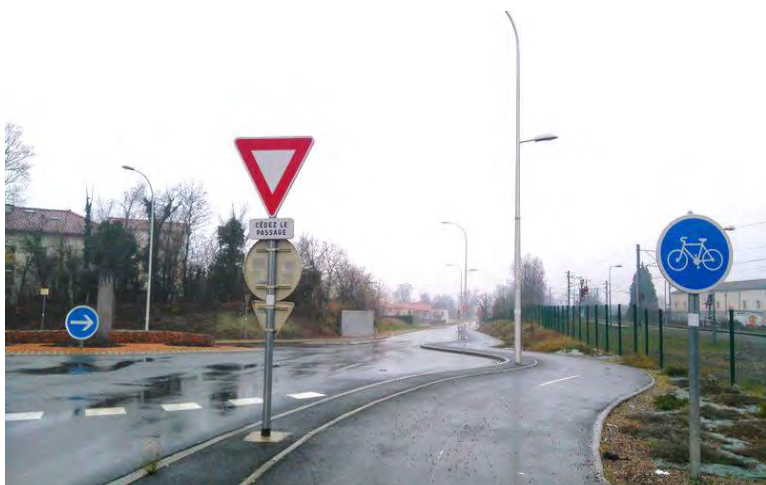
Aménagement cyclable pour franchissement de giratoire
