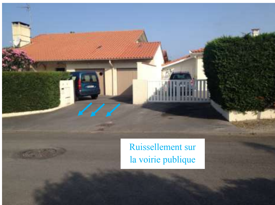
Figure 14: Exemple de ruissellement privé vers le domaine public – Rue Didier Daurat – Zone UCb
