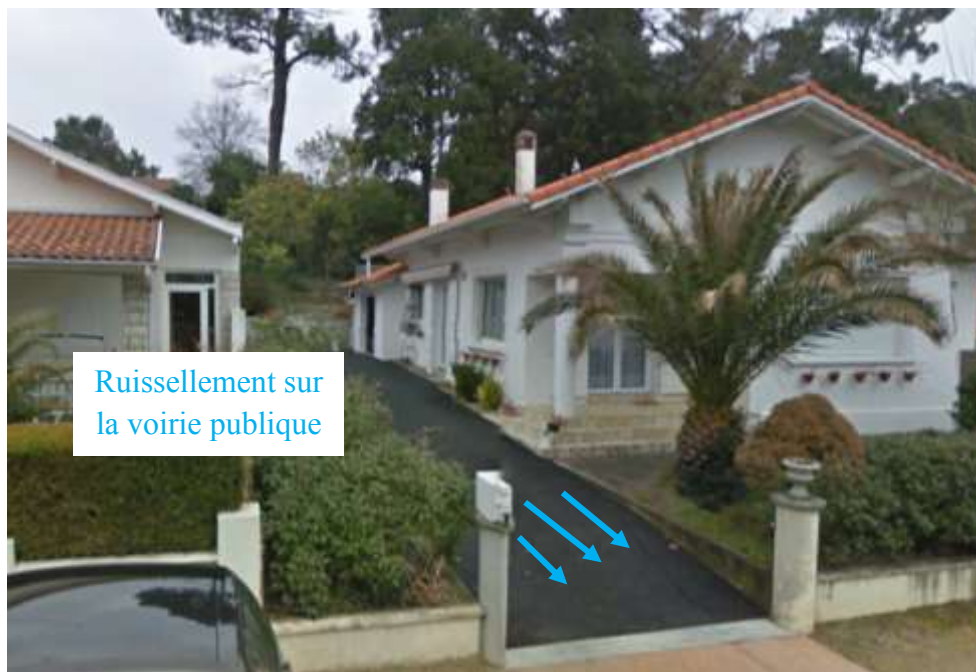
Figure 13: Exemple de ruissellement privé vers le domaine public – Avenue de la Forêt – Zone UCb
