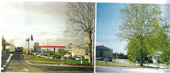
Point noir : des voitures au premier plan. Points forts : - un platane isolé, signal de l'entrée de la Z.A. - le double alignement de platanes le long de l'ancienne R.N. 7 qui traverse la Z.A. (à droite sur la photo).
