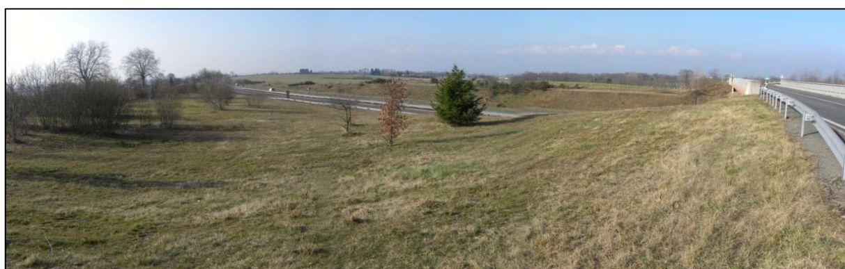
Vue depuis la bretelle de sortie de la RN82
