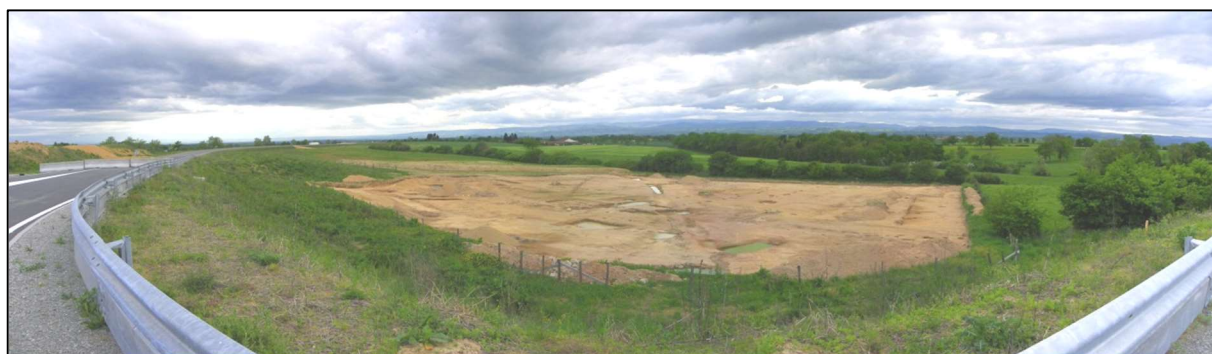
Vue d'ensemble depuis l'échangeur avec la RN 82
