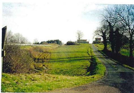
L'ancienne R.N. 7 emprunte un tracé sinueux en balcon sur le versant de la vallée de l'Ecoron (au Nord), tandis que la nouvelle R.N. 7 se réapproprie presque le tracé de la route Napoléon (à droite sur la photo).
