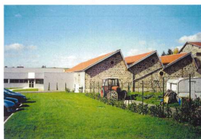
Le patrimoine bâti de la Commune est aussi caractérisé par les constructions industrielles (toiture à sedscheds autrefois, bardage métallique aujourd'hui).
