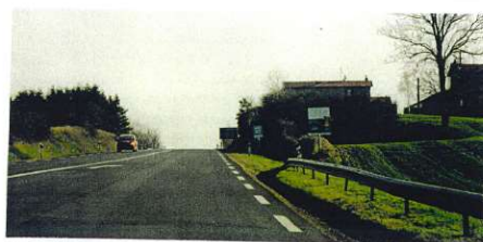
En déblai, la R.N. 7 sur le sommet du relief ne laisse percevoir aucun paysage.
