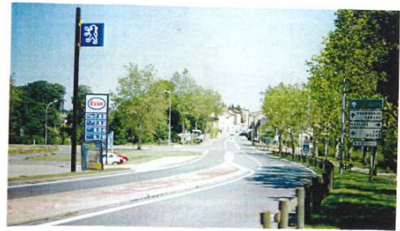
Points forts : - le double alignement de platanes le long du chemin du champ de Foire ; - les 4 platanes à l'entrée de la traversée du Bourg (résidu des alignements caractéristiques de la route nationale) - la glissière en bois, effet soigné, « village » et non routier.
