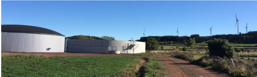
Unité de méthanisation et parc éolien de Saint-Jean-Lachalm
