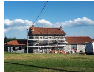
Réhabilitation à Rauret
