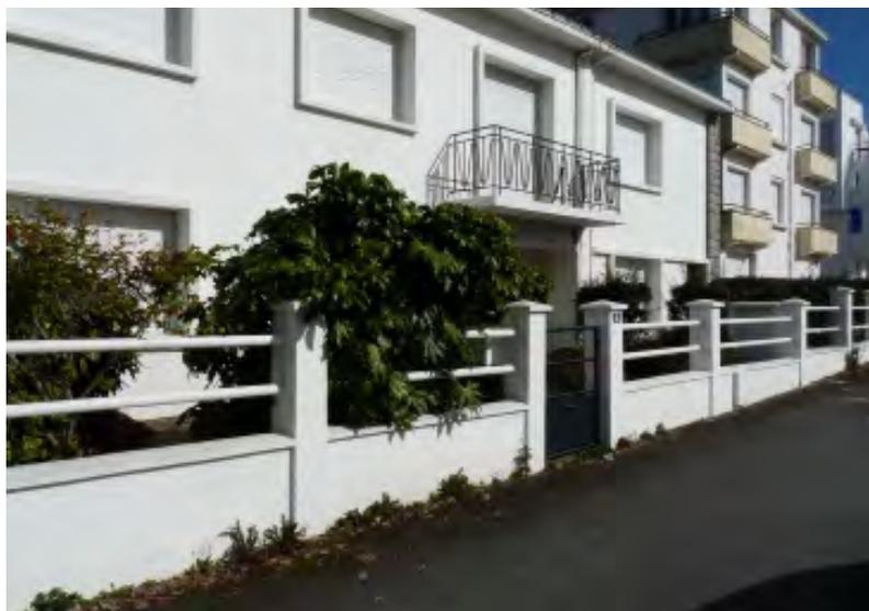
*Muret bas avec couronnement, piliers couronnés, deux lisses horizontales. Le mur est fraîchement repeint mais on peut supposer que les lisses étaient de couleur sombre, assorties au balcon et portillon. La partie pleine du portillon est alignée sur la hauteur du muret.*
