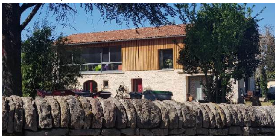
Restauration qualitative d'une grange à Vairre, (restaurant-gîte)
