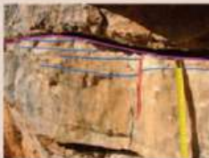
Vues de détail : la corrosion de la roche calcaire souligne sa structure interne souvent feuilletée qui permet de bien visualiser de nombreuses petites failles* normales (en rouge)
