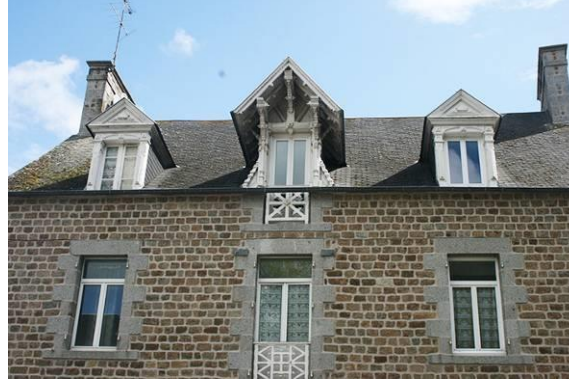
Lucarnes en bois finement travaillées
