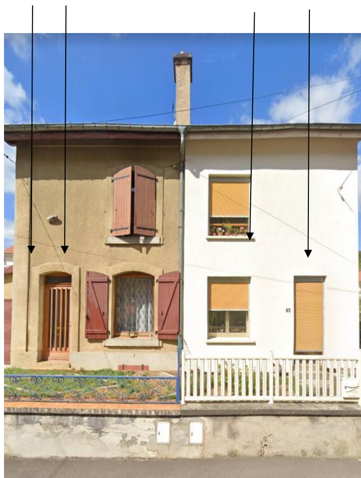
Exemple d'isolation par l'extérieur ayant entraîné la disparition des modénatures (et modification des ouvertures) sur l'une des deux maisons jumelées d'une cité ouvrière
