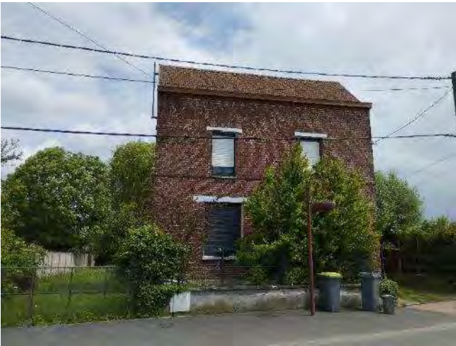
Photo 1 : Vue de la façade principale de l'habitation depuis la rue Victor Hugo.
