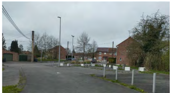
Photo 2 : Vue de l'emplacement des anciens garages vers la rue de Normandie.
