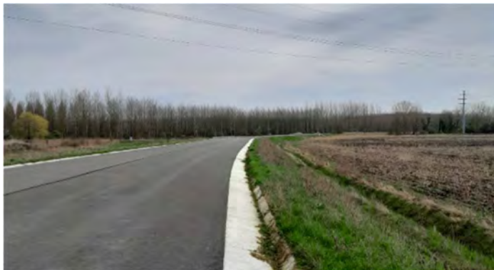
Photo 3 : vue vers l'est de la voirie aménagée au niveau de la station d'épuration (Bruay-sur-l'Escaut).
