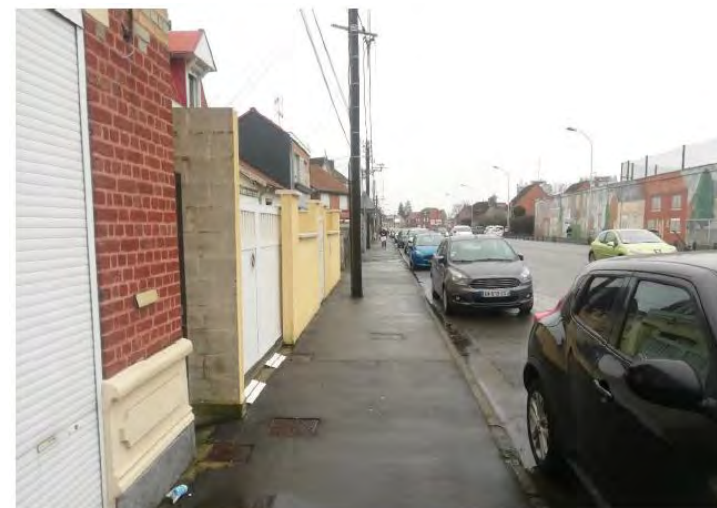
Figure 122 : Trottoir nord de la rue Lomprez
