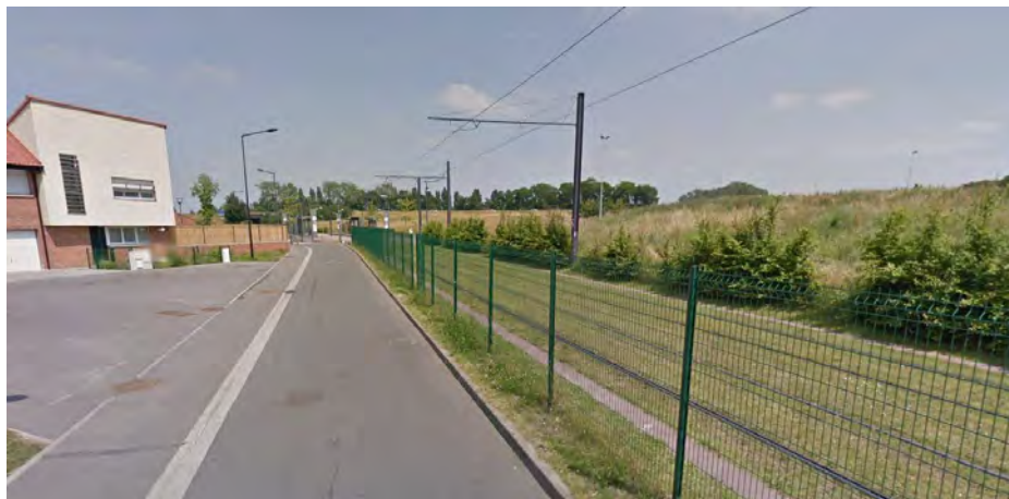
Avenue Duren et réseau Tramway vers la station Dutemple
