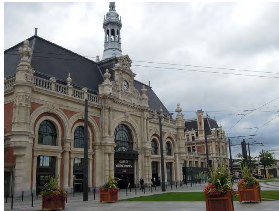
Figure 120 : Photographie de la gare de Valenciennes
