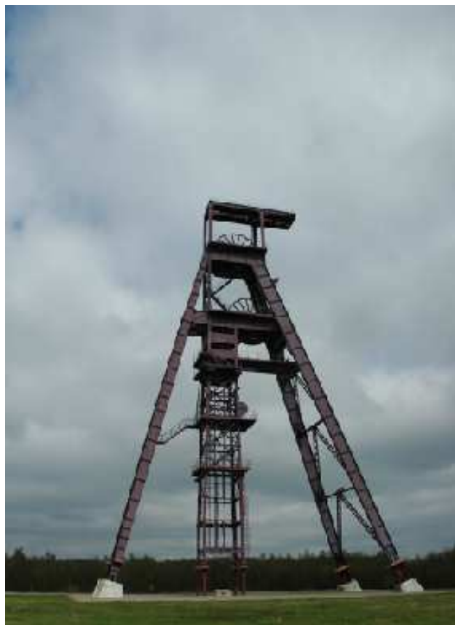
Chevalement de l'ancienne Fosse Ledoux (puit n°1), Condé-sur-Escaut.
