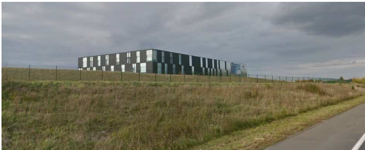
Entrée Sud du territoire depuis l'A2 sur Rouvignies – Premier bâtiment d'activité visible
