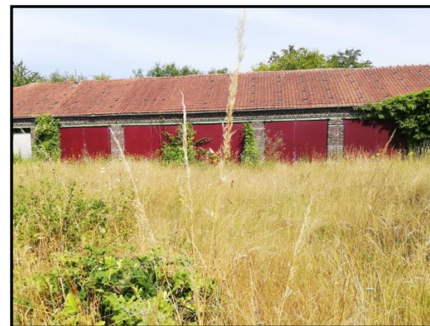
Photo 34 : Bâti désaffecté, Rainette (2019)
