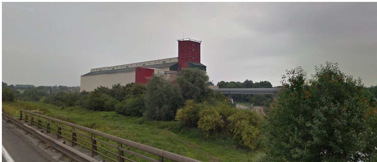
Entrée Sud du territoire depuis l'A2 sur Rouvignies – Bâtiments de stockage
