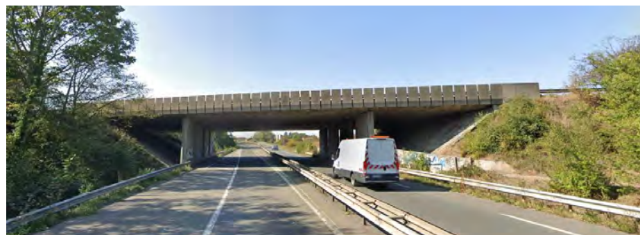
Vue de l'ouvrage d'art de l'A23 au passage des bretelles Sud-Ouest
