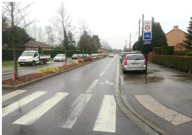
Figure 125 : Bandes cyclables sur l'avenue des Bruyères
