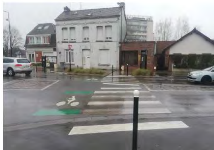
Figure 124 : Passage piéton de la rue Lomprez, à proximité de l'avenue de Denain
