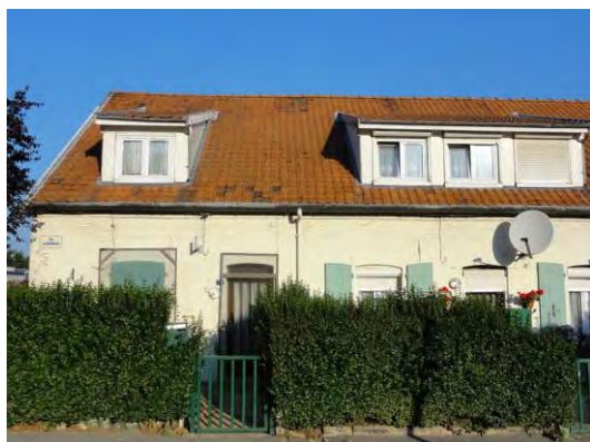
Figure 140 : Ensemble du coron de l'église
