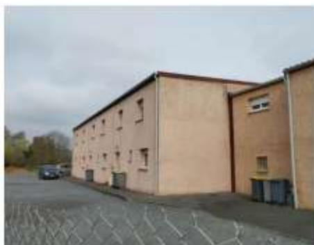
Photo 1 : Vue de l'arrière de la parcelle AM 431 côté bâti
