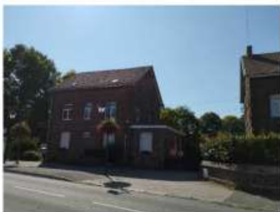
Photo 1 : Bâtiment de l'ancien CCAS (parcelle AD 60) le long de la rue des portes
