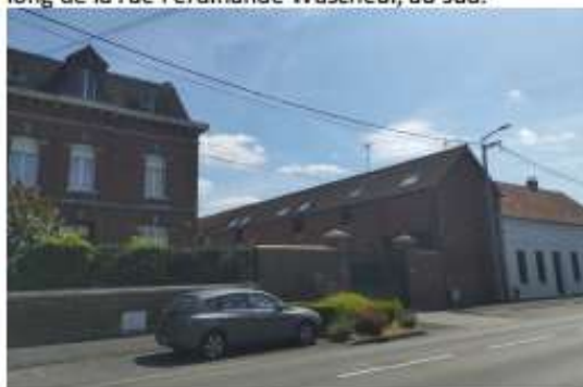
Photo 4 : Tissu bâti ancien composé de longères et de maisons de ville le long de la rue Jean Jaurès (RD 630).
