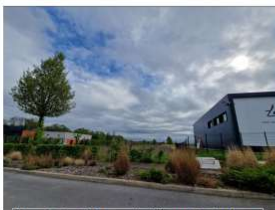
Photo 2 : Vue du futur accès à l'extension de la zone d'activité commerciale de l'Ecaillon
