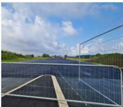
Photo 1 : Vue vers l'Ouest des travaux du contournement nord au niveau du giratoire de la D375 et de la rue Victor Hugo
