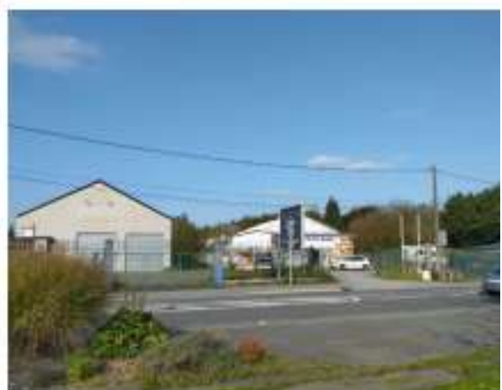
Photo 2 : Vue des bâtiments existants sur l'emprise du projet depuis l'avenue Jean Jaurès (RD 630).
