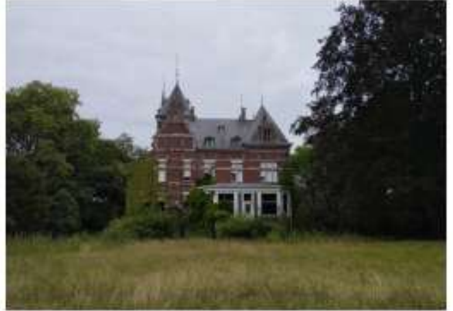
Photo 2 : Vue de la façade arrière de la maison de maître depuis l'intérieur du parc.
