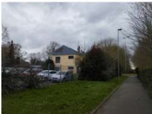
Photo 1 : Vue de l'ancien logement de fonction de l'école du Rôleur
