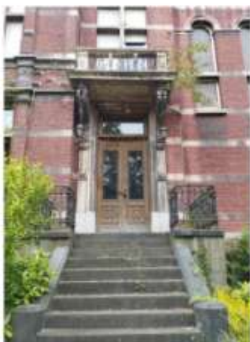
Détail de l'emmarchement, des éléments de ferronnerie et maçonneries accompagnant la porte d'entrée
