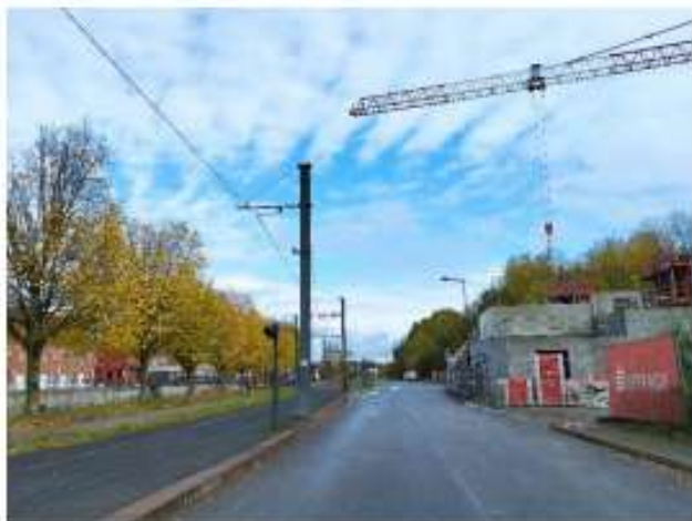
Photo 1 : Vue de l'EPHAD en construction depuis le Quai du Petit Rempart, Rive droite
