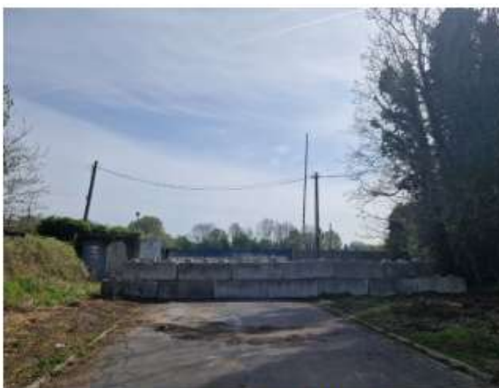
Photo 2 : Vue de l'entrée de la parcelle
