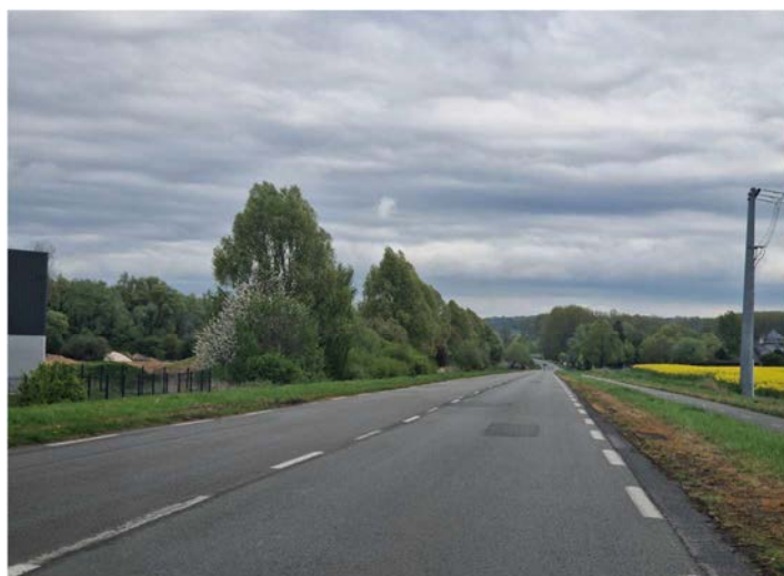
Photo 3 : Vue de l'extension de la zone d'activité commerciale de l'Ecaillon depuis la RD 40
