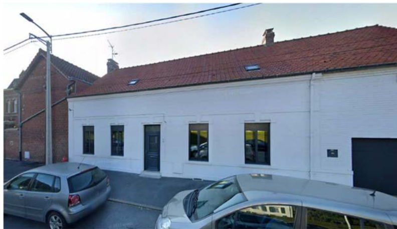
Photo 2 : Vue des bâtiments sans intérêt patrimonial des parcelles B 3039 et B 7656 depuis la rue Jean Jaurès, identifiés par erreur sur le plan de zonage et l'OAP
