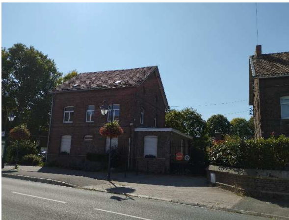
Photo 1 : Bâtiment de l'ancien CCAS (parcelle AD 60) le long de la rue des portes
