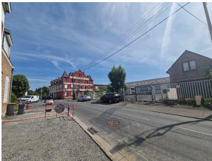
Photo 1 : Vue des bâtiments en friche depuis la rue de Romainville
