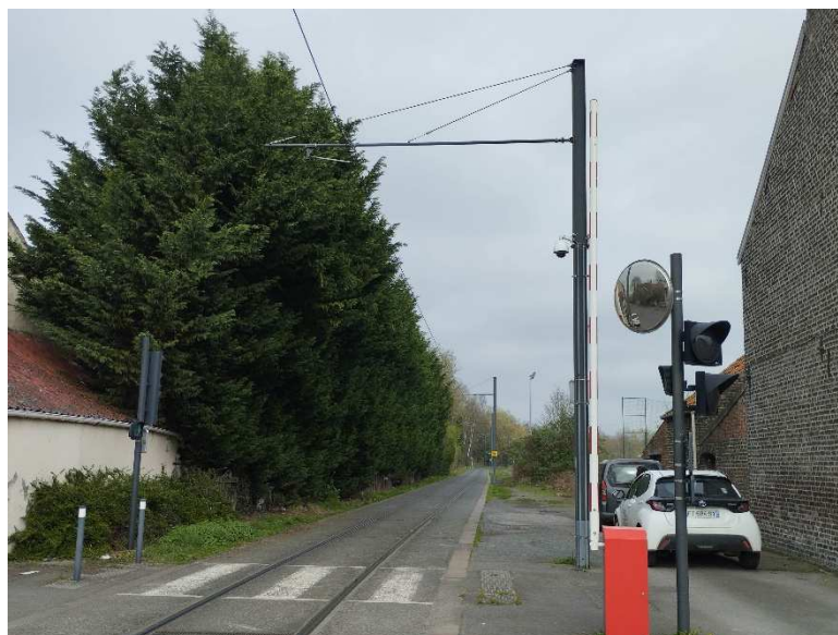
Photo 1 : Vue de la voie de tramway depuis la rue Augustin
