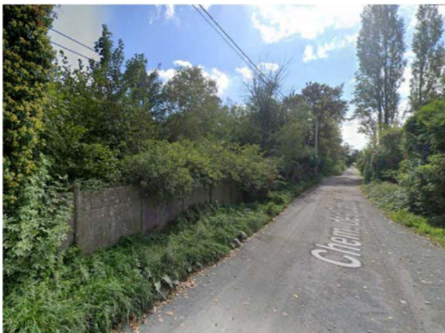
Photo 1 : Vue du site à renaturer en lien direct avec la forêt urbaine
