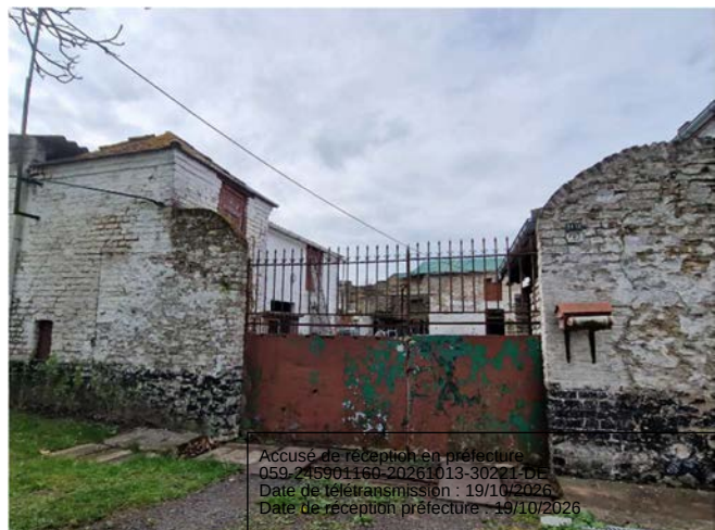
Photo 3 : Vue de la façade des bâtisses
