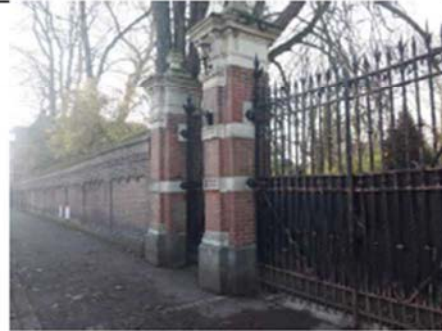
Mur de clôture, piliers et portail côté rue des Déportés
