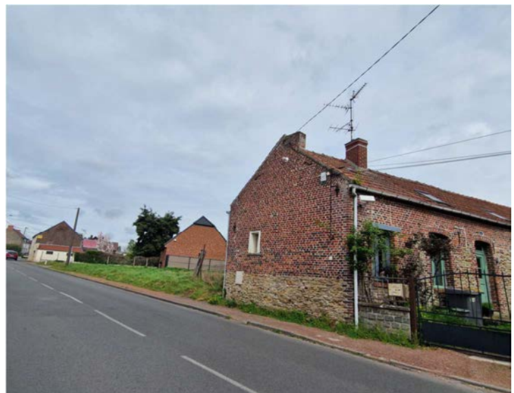
Photo 2 : Vue d'ensemble depuis la rue Jean Jaurès
