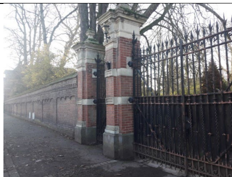
Mur de clôture, piliers et portail côté rue des Déportés
