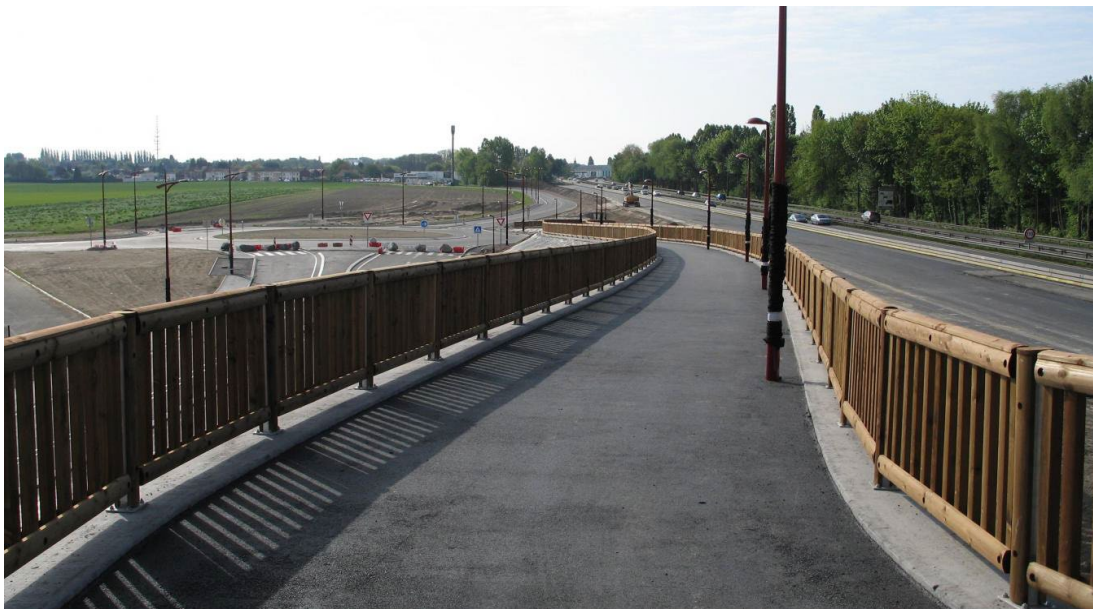
Nouvelle passerelle piétonne traversant l'A23
