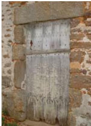
*Portes traditionnelles à planches verticales, assemblées à rainures et languettes. Des pentures métalliques sont fixées aux planches par des clous forgés dont la pointe est rabattue. Les portes étaient «réparées» par des entures en parties basses.*
