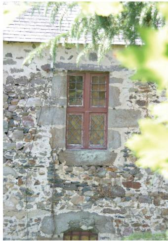
*Menuiserie XVII<sup>e</sup> avec panneaux de verre mis en plomb, carrés et losanges*
