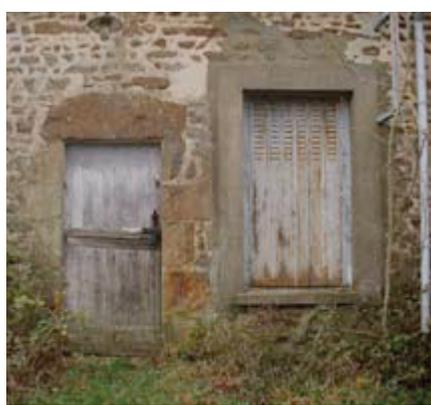
L'utilisation du béton, de parpaings de ciment, ou du ciment est incompatible avec des maçonneries anciennes en moellons.
