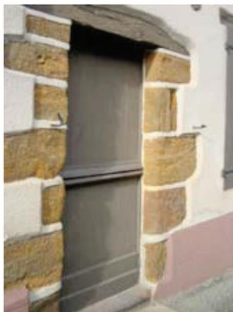
L'enduit réalisé n'arrive pas au nu des pierres d'encadrement, mais est en surépaisseur par rapport au nu de la pierre formant une boursoufflure inesthétique.
