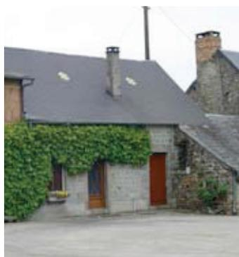
L'enduit a été réalisé au ciment, sur lequel a été redessiné un appareil de fausses pierres.
