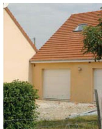
Les baguettes en plastique blanc mises en œuvre dans les angles sur cette maison, sont trop visibles et donnent un aspect trop raide à la maçonnerie.
