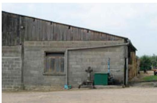
*Les murs en parpaings non enduits ou le bardage en tôle non peinte, brillant au soleil, ne sont pas adaptés.*
