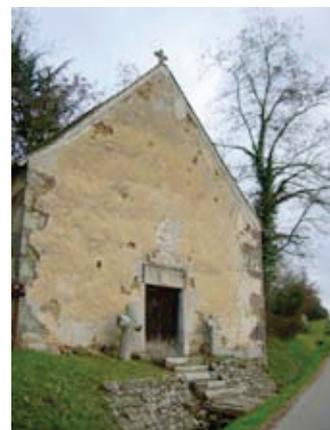
Deux exemples d'enduit «plein» sur des maçonneries anciennes, arrivant au nu des pierres d'encadrement. Les enduits sont aux tons et à la granulométrie des sables naturels non tamisés, en parfaite harmonie avec la pierre locale.
