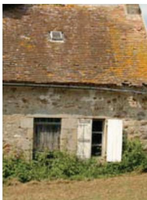
*Fenêtre à 6 carreaux et ses volets traditionnels à lames verticales et barres horizontales (barres vues volets fermés) dans une maison rurale du XIX<sup>ème</sup>.*
