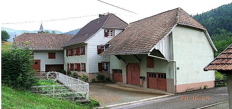
Ancien moulin à Rimbach-près-Masevaux, construit au bord du ruisseau Kerbach dans la 1ère moitié du 19 ème siècle, inventorié notamment pour l'état de conservation des bâtiments et la présence de linteaux en arc segmentaire et demi-croupes.
