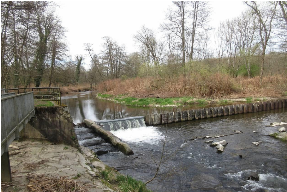
Ouvrage en travers sur la Doller pour la prise d'eau du Steinbaechlein à Burnhaupt-le-Bas (CLIMAX, avril 2017)
