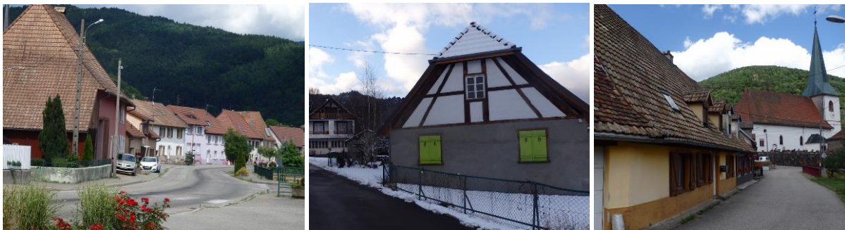
1.- Alignement de maisons anciennes sur la rue principale à Dolleren. / 2.- Maison à colombage rénovée dans l'esprit de l'ancien dans le centre de Masevaux-Niederbruck (Niederbruck) / 3.- Alignement de maisons basses dans le centre ancien de Sewen (CLIMAX, 2017-2018).
