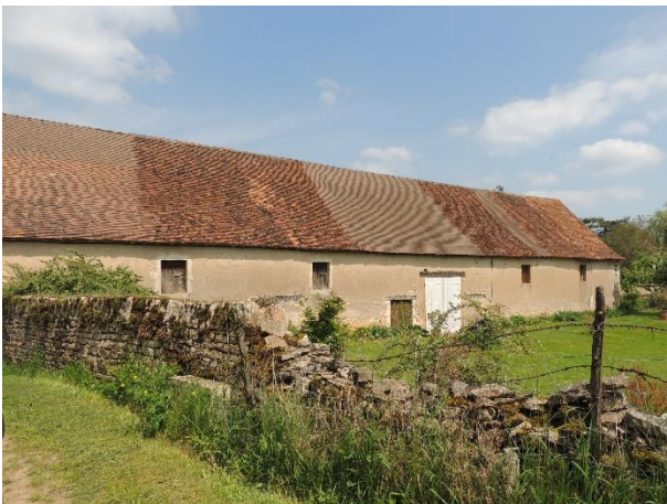
Longères parallèles à la route, murs en pierre, Sercy
