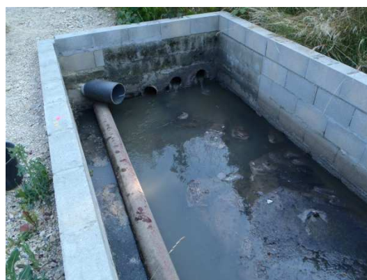
Chambre de dessablage à ciel ouvert du DO n°13, structure en parpaing sur 2,5*5 m
