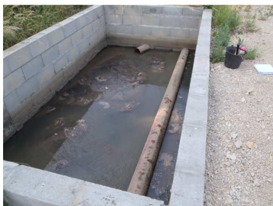
Chambre de dessablage à ciel ouvert du DO n°13, structure en parpaing sur 2,5*5 m
