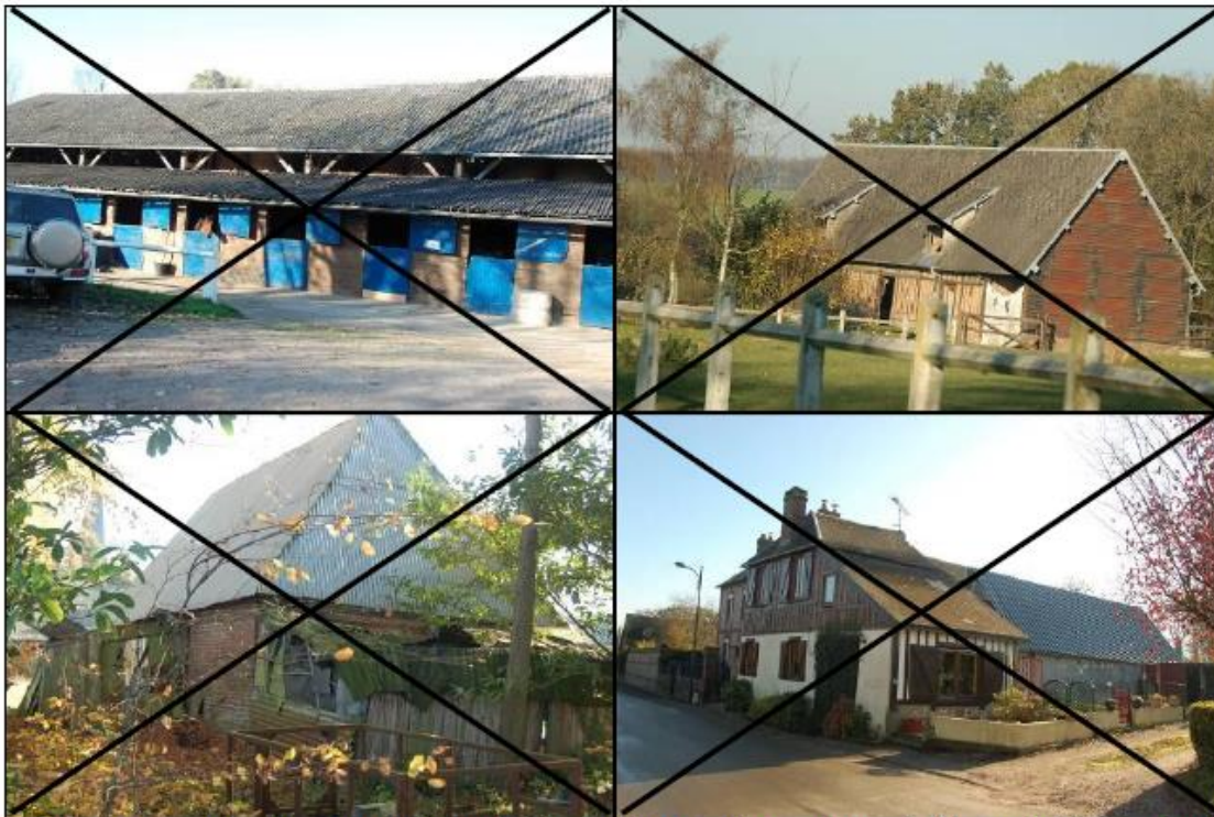
A proscrire : plaques bitumée ondulée / ardoise fibro-ciment / tôle ondulée / ardoise fibro-ciment et bac acier
