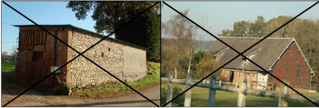
A proscrire : agglos non revêtus / tôle ondulée sur le pignon
