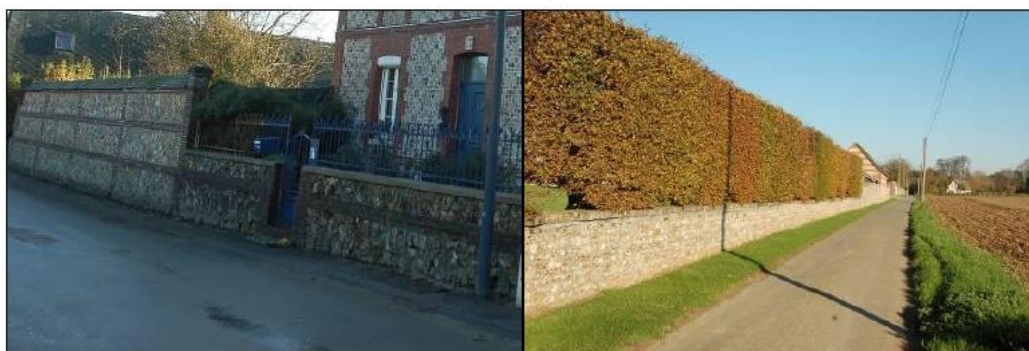
Mur de clôture avec grille / mur bahut doublé d'une haie végétale
