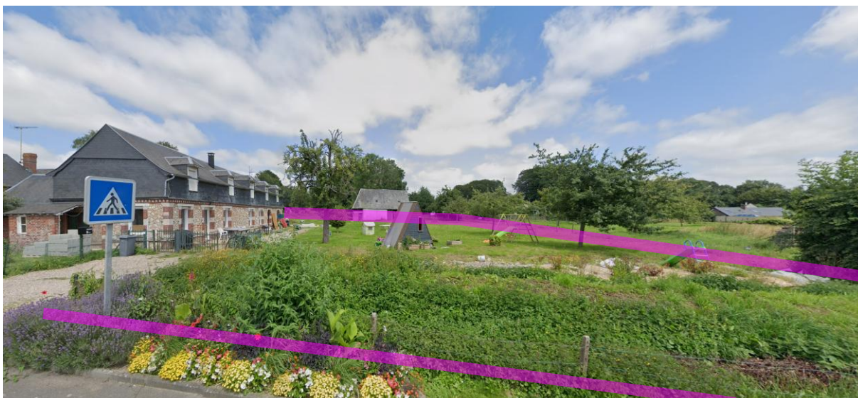
Vue sur l'habitation existante, dont le terrain pourrait éventuellement être redivisé pour accueillir un nouveau logement (source Google Street View 2021)
