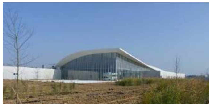
Piscine intercommunale à Bailly-Romainvilliers — Source : Archiguide
