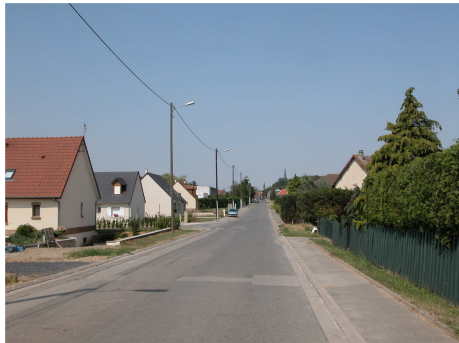
Lotissement situé à l'entrée sud de Villers-Bretonneux, sur la D23
