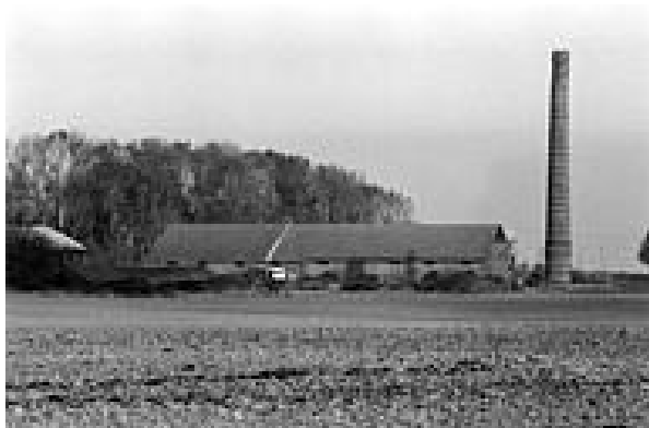
Ancienne brasserie de Villers-Bretonneux
