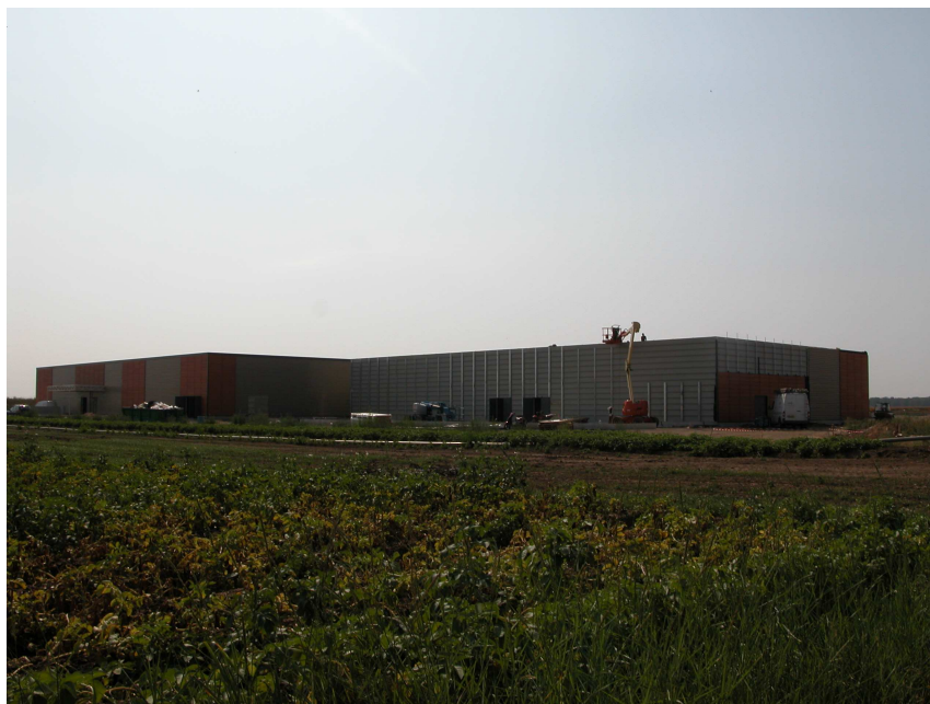
Bâti industriel récent
