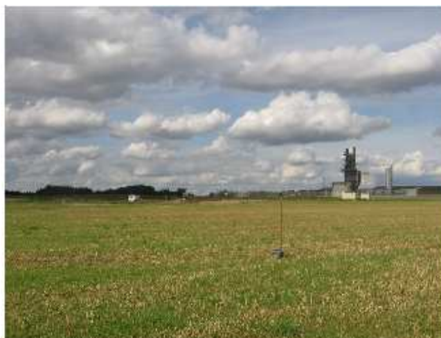
Illustration 18: Photographie du point 6, les "Enrobés du Val de Somme" et voie de contournement en fond
