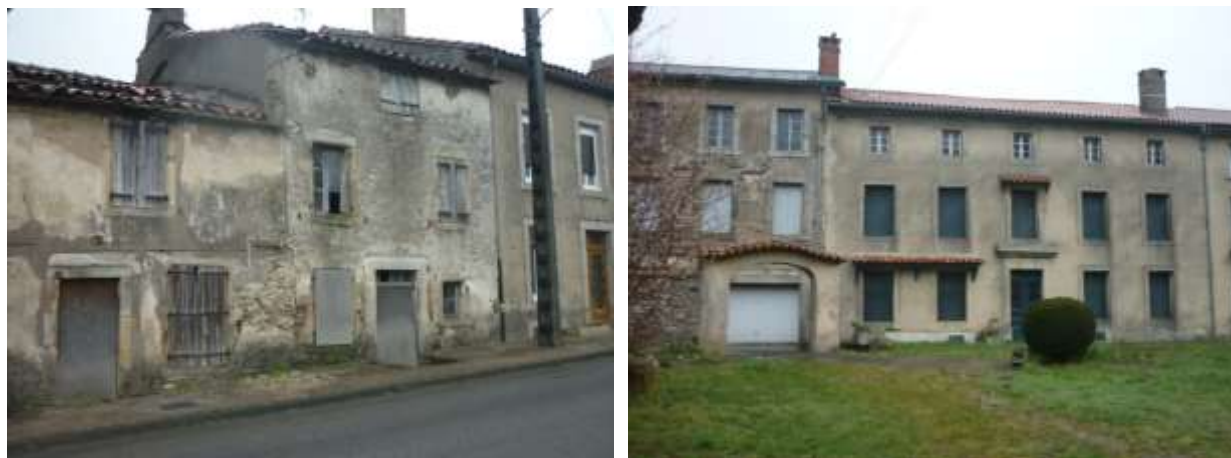
Figure 24 - Des habitations vacantes dans le centre ancien de Labastide-Rouairoux
