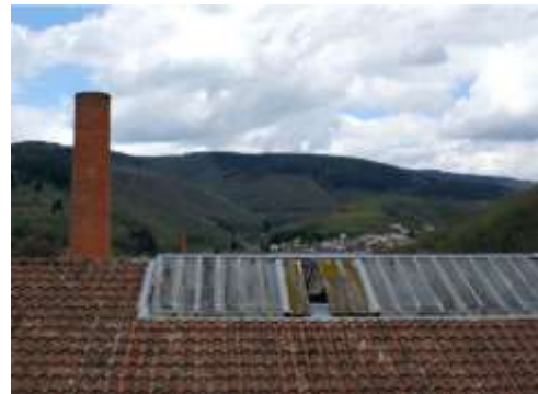
Figure 60 – Ancienne cheminée industrielle, www.cc-haute-vallee-thore.fr
