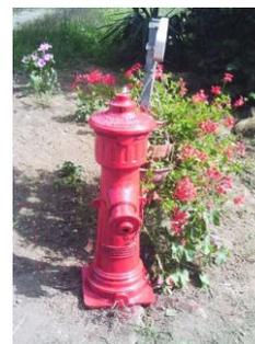
Les raccords de sortie sont des raccords de type aspiration/refoulement (DSP) utilisés par les engins sapeurs-pompiers du département.
