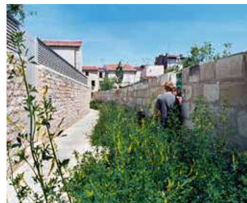
Création de venelles piétonnes, Saintes (17), bnr Architectes
