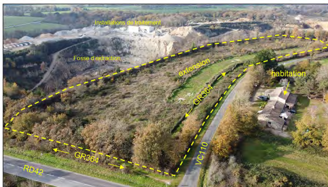
Figure 15 - Vue aérienne de l'extension depuis le sud
