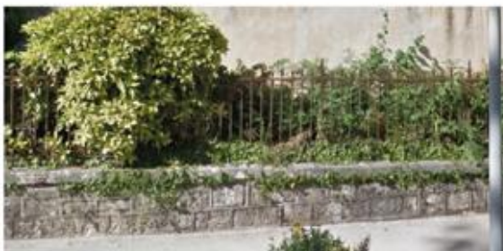
Clôture fer forgé sur mur bahut - 4 rue du Lomont
