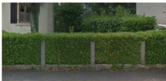
Clôture végétale, grillage et socle béton - 4 rue du Lomont
