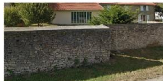
Muret de pierres sèches - 4ter rue du Lomont
