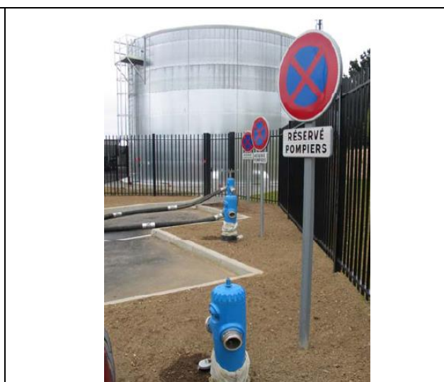
Réserve aérienne équipée de 3 poteaux d'aspiration de 150 mm
