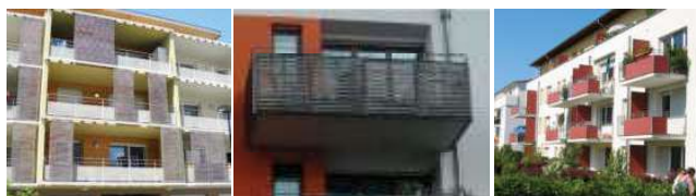
Des garde-corps bien conçus (une partie pleine opacifiée par du verre opalescent, des lattes de bois faiblement ajourées, du métal déployé...) donnent une intimité suffisante aux habitants pour que ces derniers ne souhaitent pas rajouter des clostras ou canisses.
