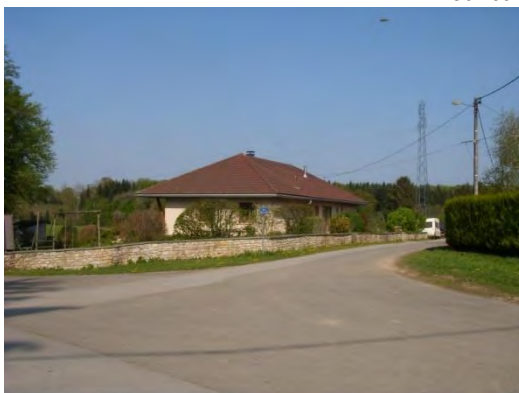
Construction intermédiaire rue des Carrières
