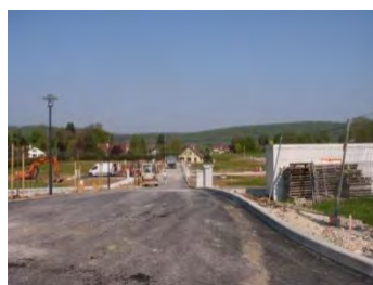
Lotissement en cours de construction entre la rue d'Osse et la Grande Rue
