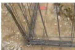
Nœud de chaînage - Continuité mécanique
