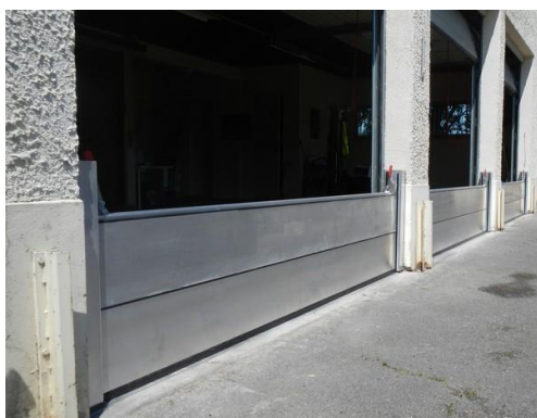
Exemple de batardeau (source : Hydroprotect)
