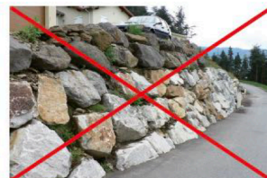
Exemple d'enrochements de type cyclopéen
