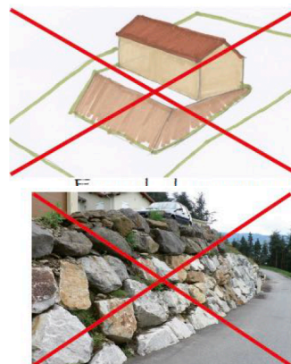
Exemple d'enrochements de type cyclopéen
