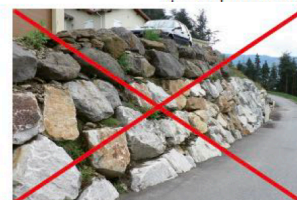
Exemple d'enrochements de type cyclopéen
