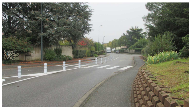
Traitement de la voirie sur la Départementale 176 à l'entrée Ouest de la commune : trottoirs, éclairage, traitement paysager et routier
