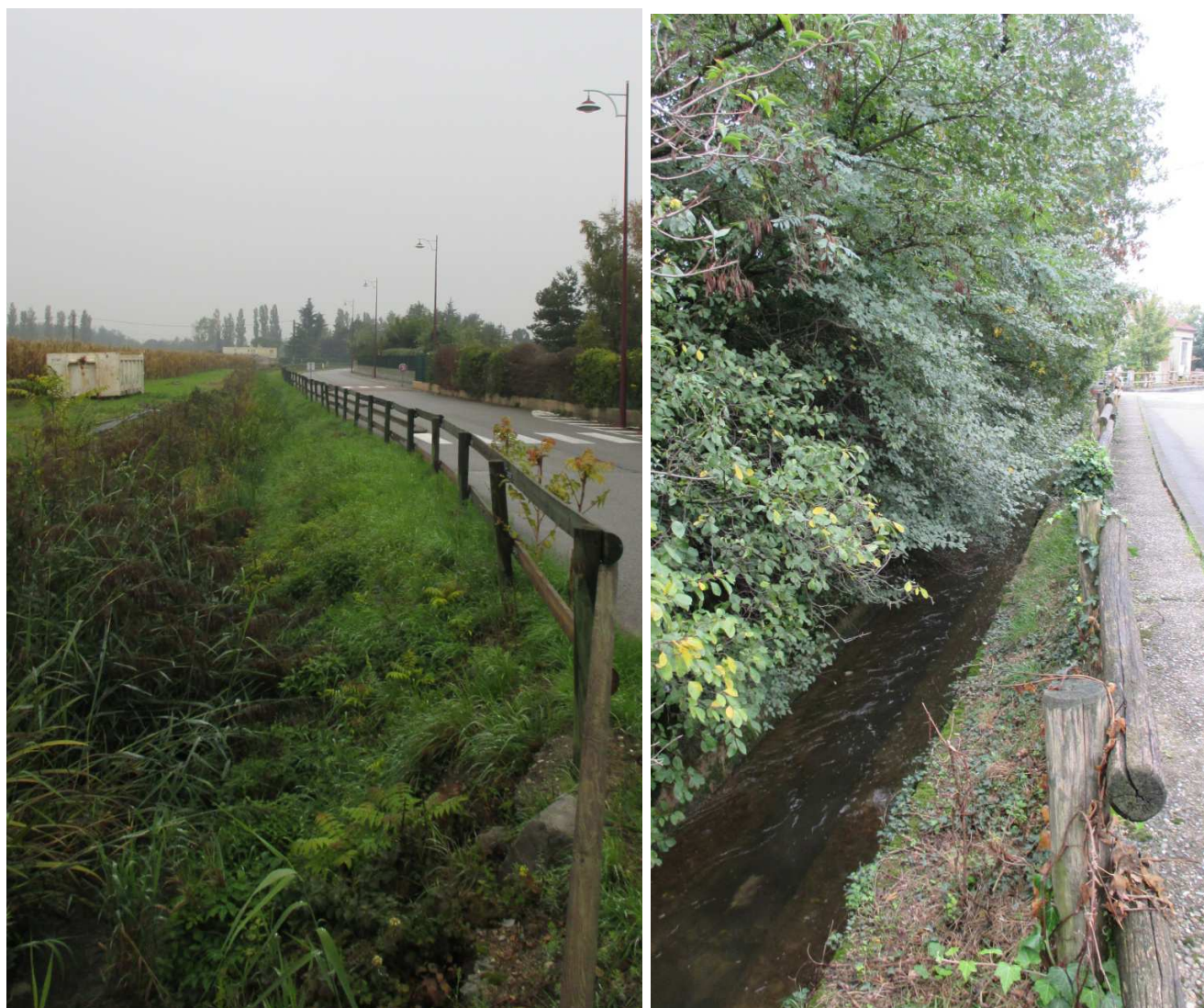
Le canal du Béal-Crapaud et le canal secondaire de la Bourne
