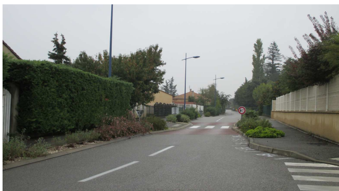
Traitement de la voirie sur l'Avenue de Provence : trottoirs, éclairage et traitement paysager et routier
