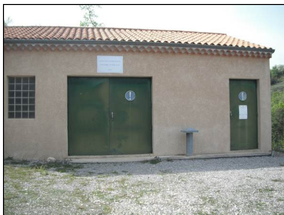
Photo 1 : Station de traitement de La Bourne
