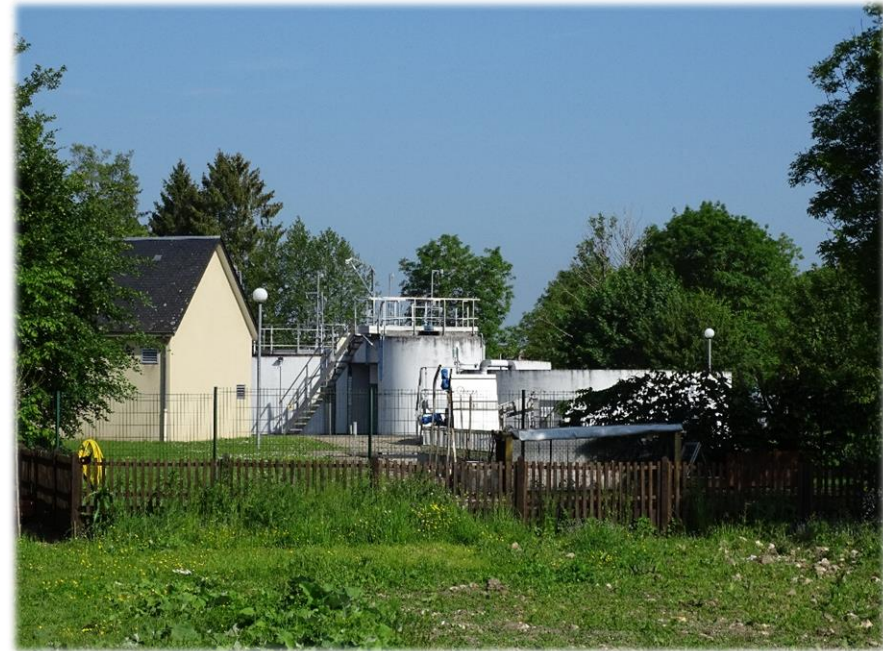
Station d'épuration de Beaumont-le-Roger (Source : 2AD)
