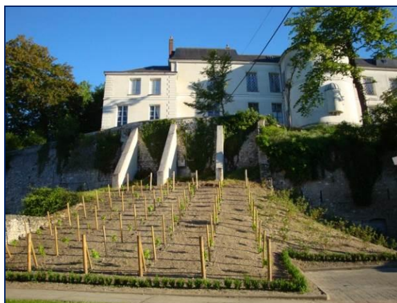
Façade arrière visible depuis le village
