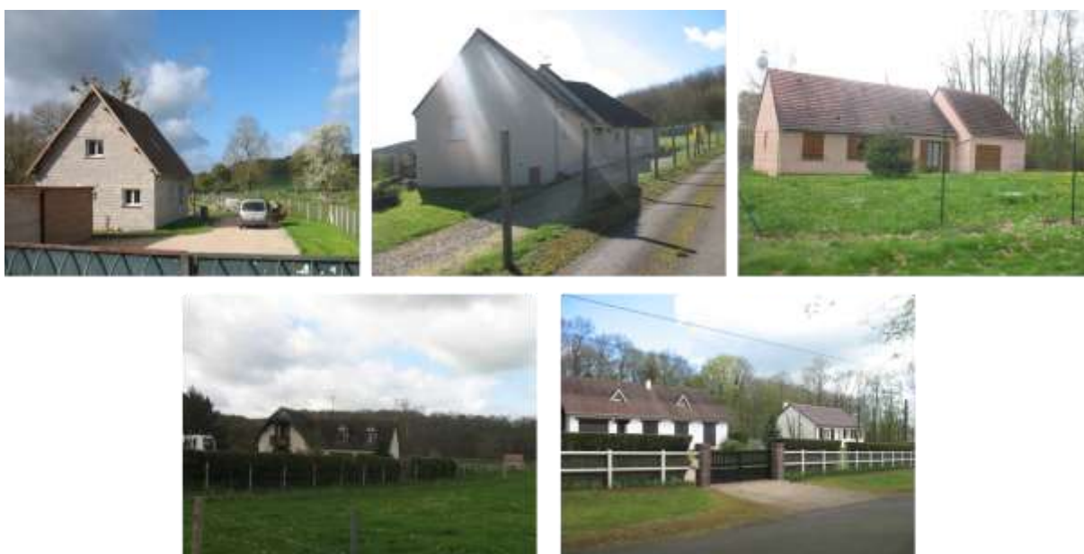
Utilisation de matériaux standardisés et implantation systématique au centre de la parcelle
