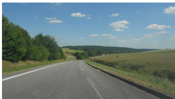
Vallons présent au Nord du territoire, en sortie de la RD6014
