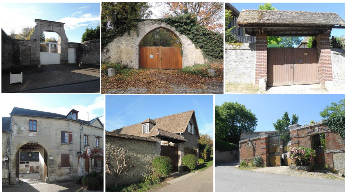
Les murs de clôture et les entrées de propriétés participent à la qualité du cadre de vie
