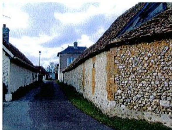
Le mur d'enceinte Sud de l'exploitation n°3
