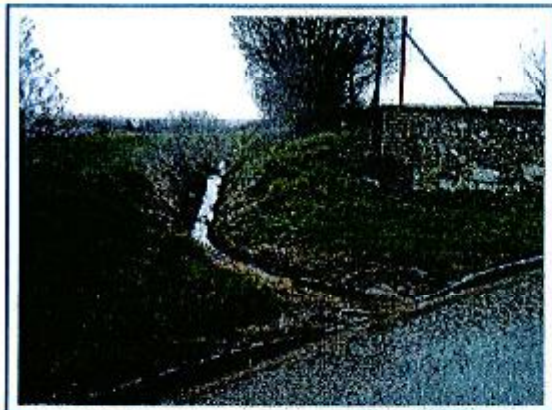
Fossé qui récolte les eaux ruisselées sur le plateau en amont (57)
