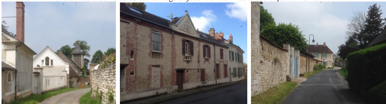
À gauche la rue du Clos de l’Aître, au centre la rue de Vernon, à droite la rue Robert-Connan cette dernière ainsi que la rue du Clos de l’Aître particulièrement réussies grâce à l’absence de bordure (notamment béton) et à la bande plantée en pied de murs.
