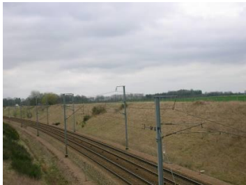
La Voie Ferrée
