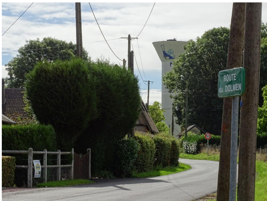
Château d'eau de Saint-Léger (Source : 2AD)
