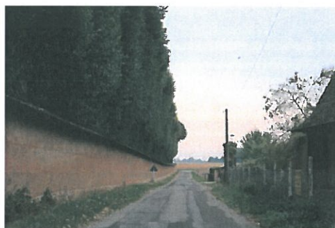
Mur en bauge du château
