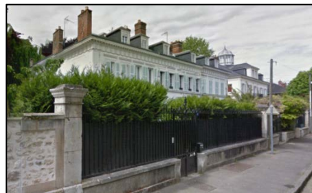
28. Le linéaire de maisons et immeubles bourgeois situé du 3 au 21 avenue Gambetta ;
