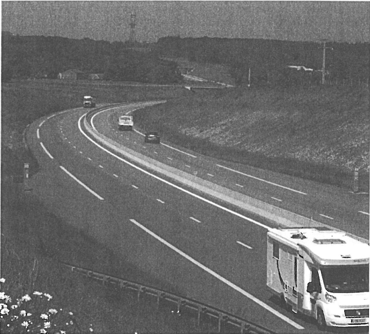
Autoroute A 28 vue de la RD 124
