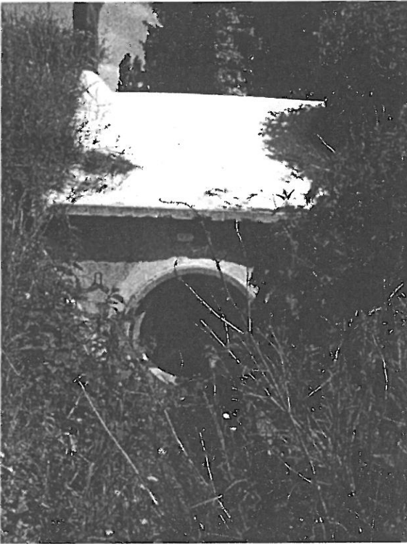
fossé de drainage
